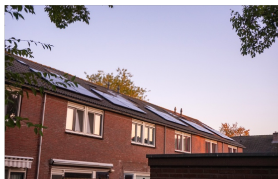
Geplaatste zonnepanelen aan de Wevershof en Waldhoornlaan met project HBV voor Zon
